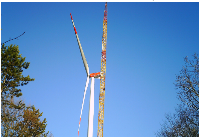
Bauarbeiten am Windpark Kulsheim
